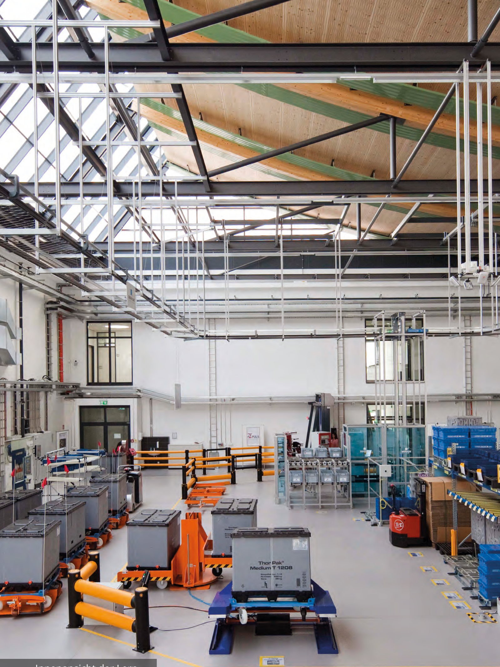
Innenansicht der Lern- und Musterfabrik
