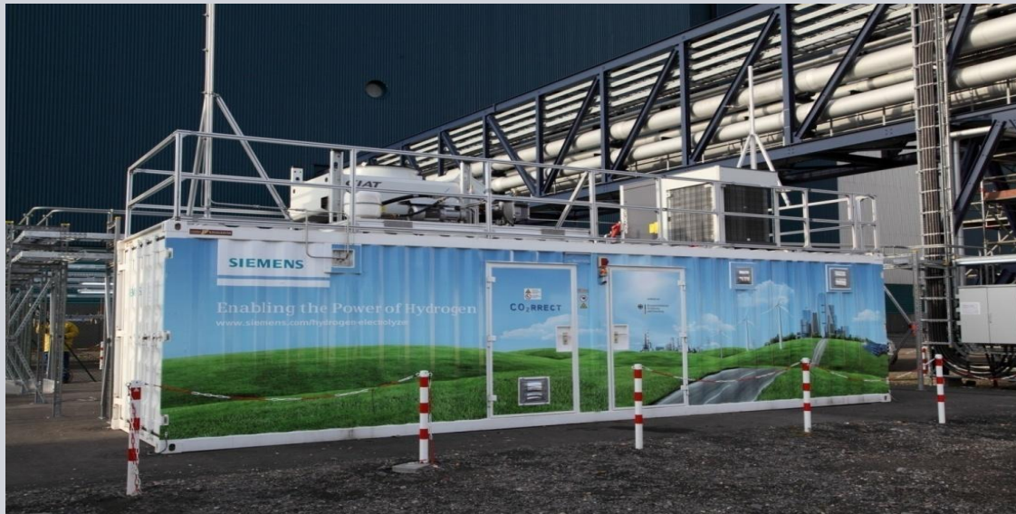
Installation des PEM-Elektrolyseurs bei RWE in Niederaußem
