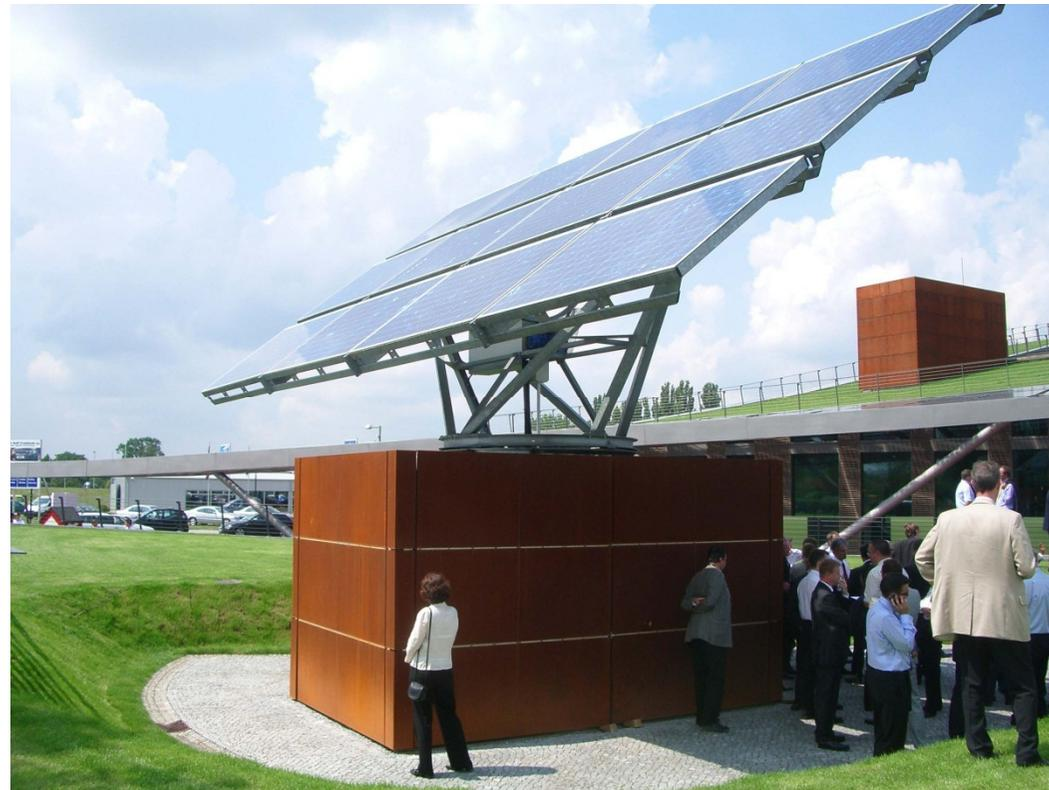
Redox-Flow Batterie (100 kWh / 10 kW) mit drehbarer Photovoltaik, Fa. Cellstrom und Younicos AG
