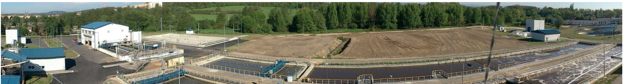
Abbildung 2: Kläranlage in Cheb (Quelle: Chevak Cheb, a.s.)
