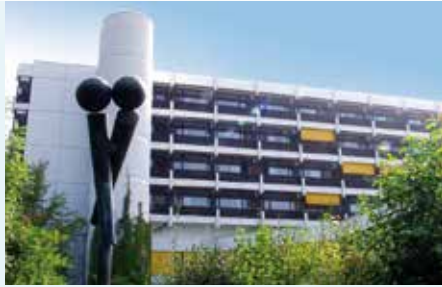
■ Krankenhaus Landshut-Achdorf Akademisches Lehrkrankenhaus der TU München Telefon: 0871. 404-0
