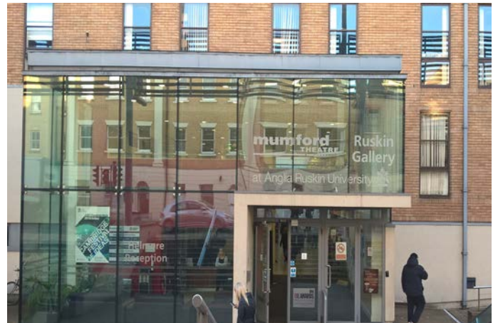
Eingangsbereich der ARU
