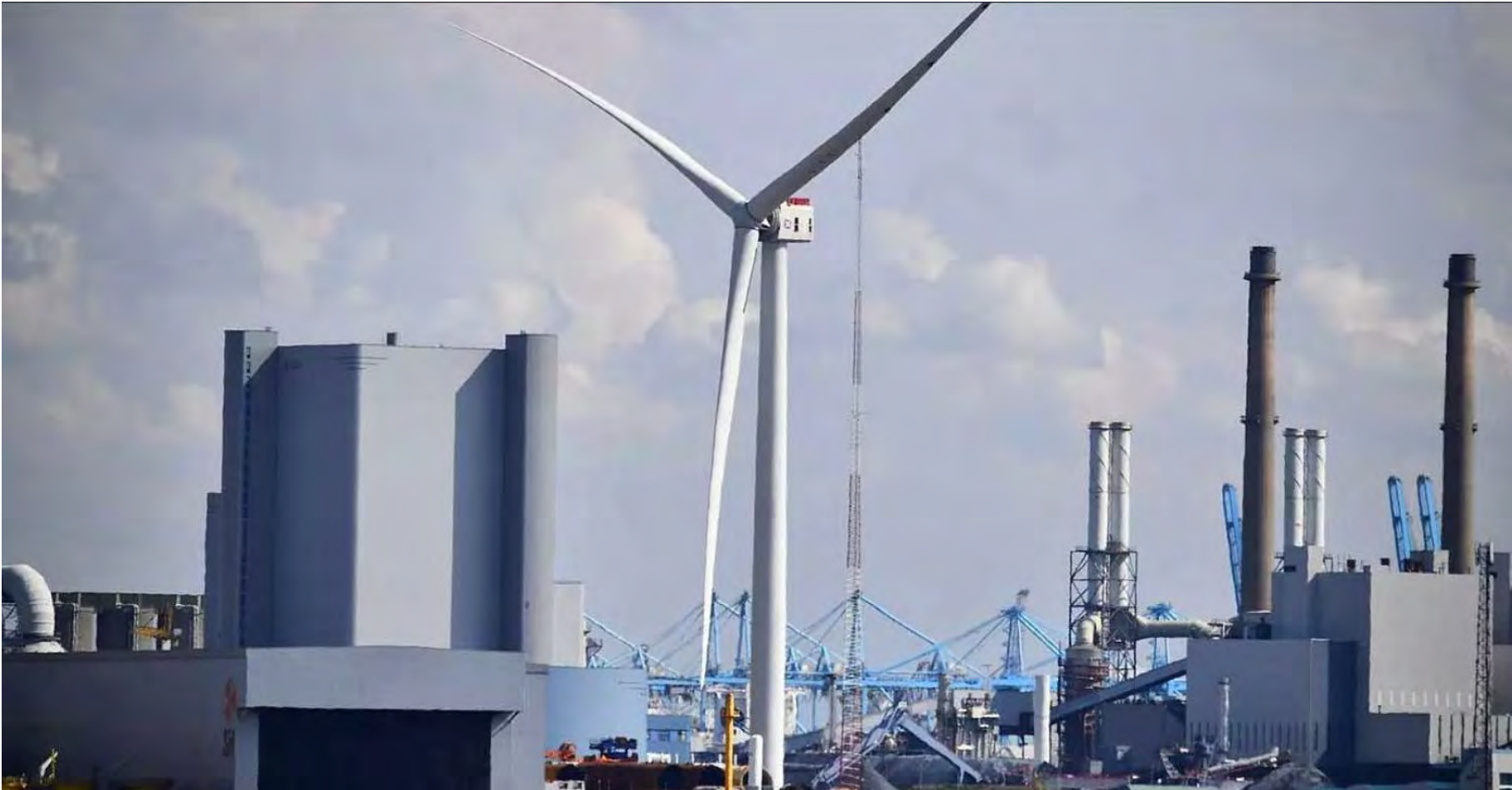
Haliade 14 MW von GE Okt.2021 in Rotterdam zur Erprobung aufgestellt. Soll in der Nordsee 74 Mio. kWh/a erzeugen. Flügelänge 107 m. Anlagenhöhe bis zur Flügelspitze 260 m
