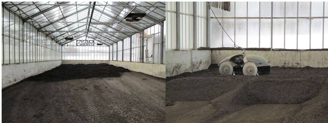
Abbildung 1: Solare Klärschlamm-trocknung Markt Essenbach [Quelle: Markt Essenbach, Kläranlage]
