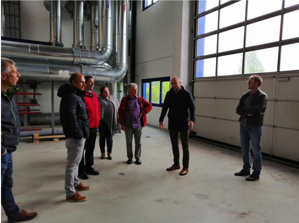
Abbildung 1: Besichtigung der AFK Geothermie
